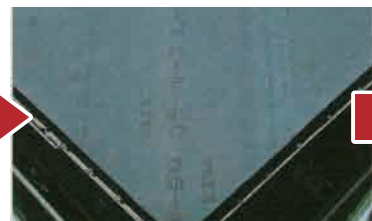
古い化粧スレート屋根の上に 改質アスファルトルーフィングを敷く
