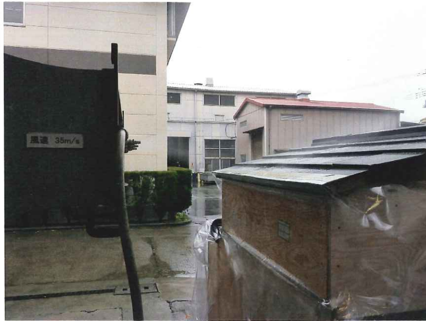
写真-3 送風散水状況 風速：35m/s
